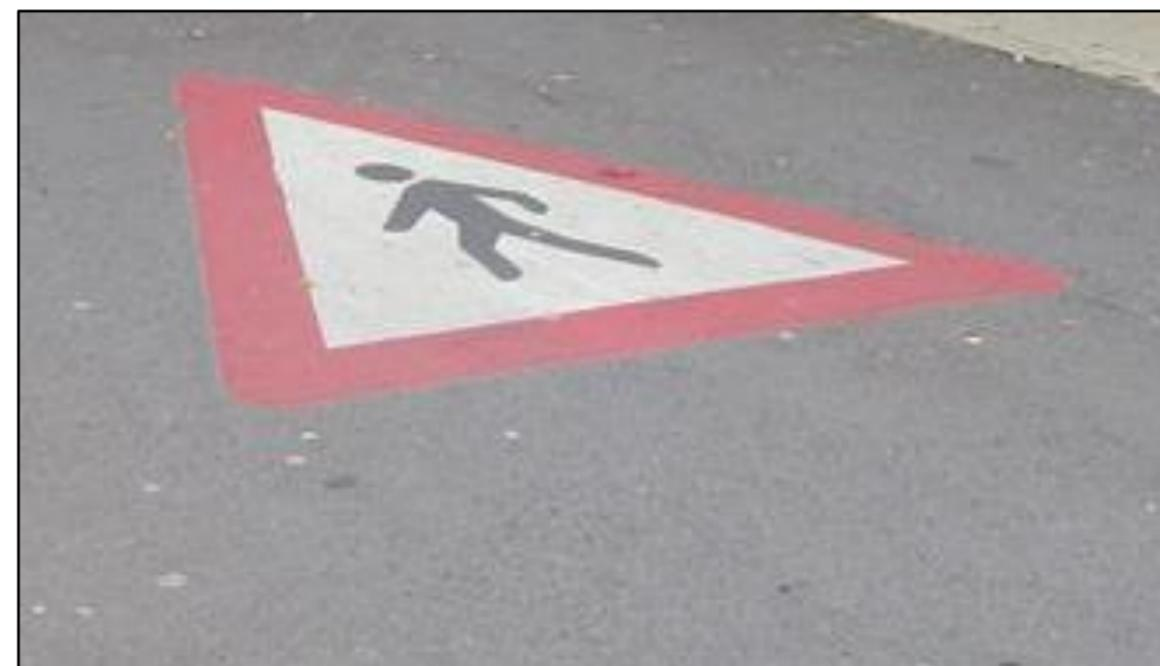
*Imagen 3. Ejemplo de señalización horizontal en zona de tránsito peatonal. Fuente: elaboración propia.*
