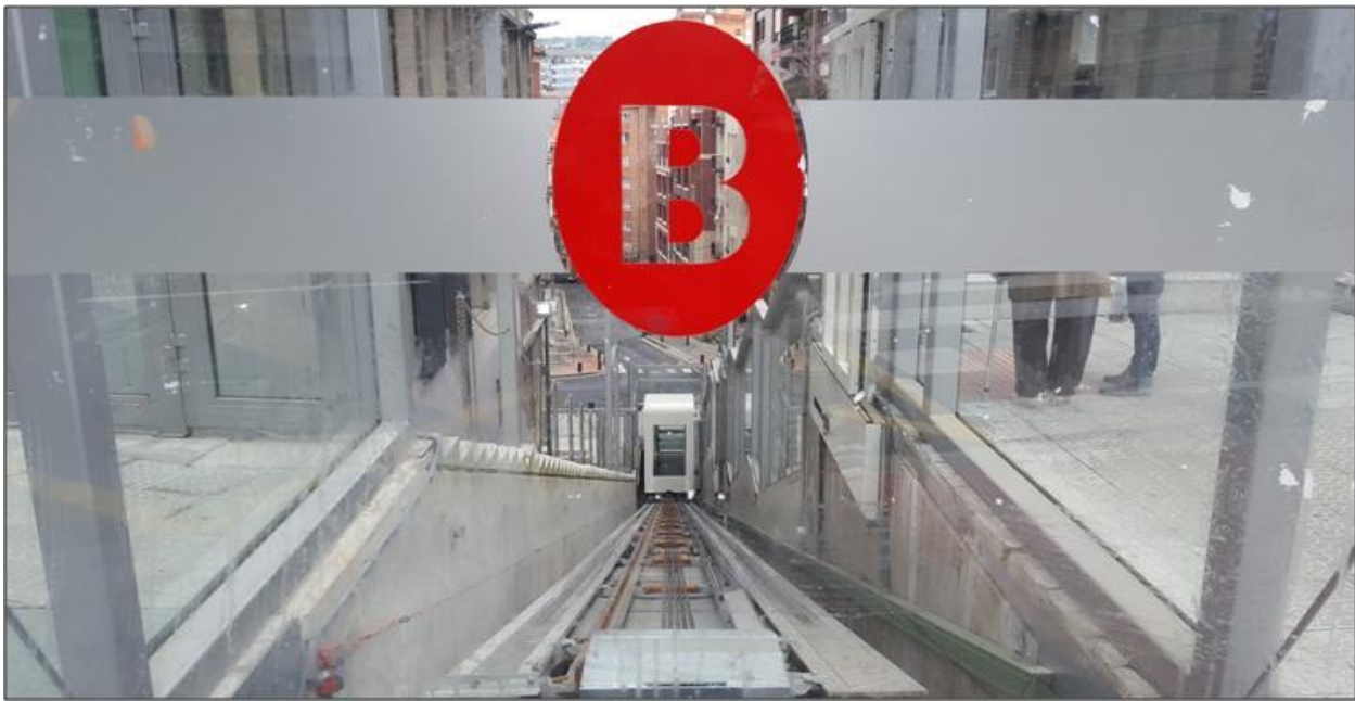
7. irudia. Bilbon instalatuta dauden hainbat igogailu-tipologia. Iturria: Bilboko Udala.
